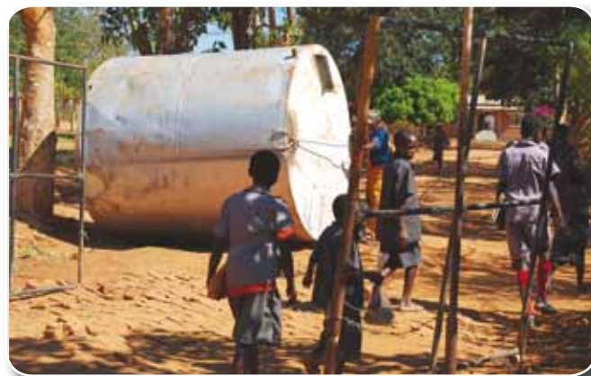
Instalowanie tanku na wodę.
