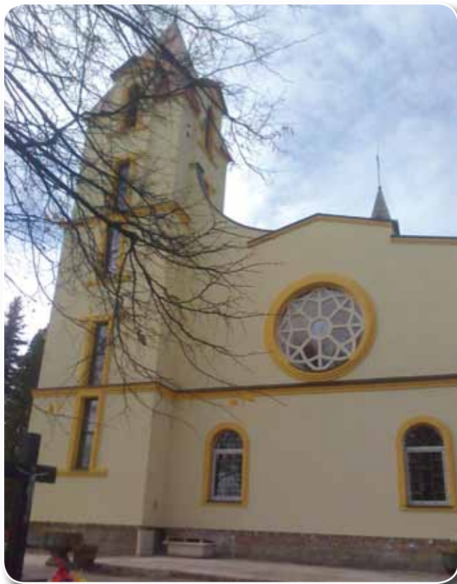
Niedawno (2012) dobudowana wieża kościoła w parafii św. Anny na Greczanach w Chmielnickim.
