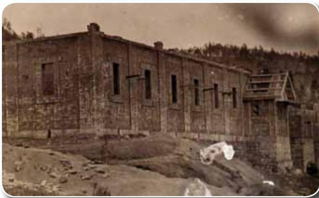
Budowa szpitala w Maranie.
