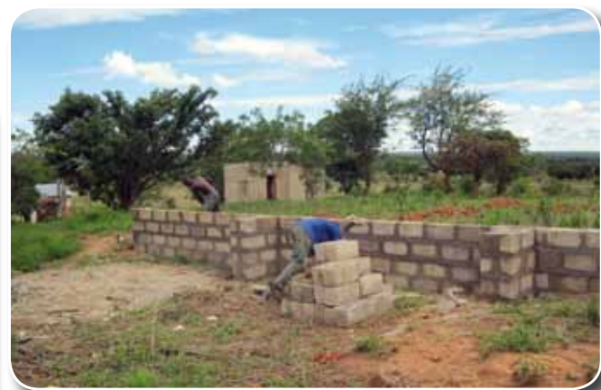
Rozpoczęta budowa nowego kościoła.
