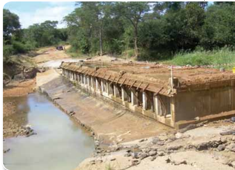
Prace postępują, ale kiedy będzie gotowy most?
