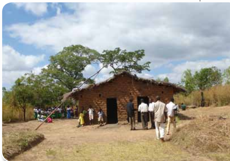
Kościół stacji misyjnej.
