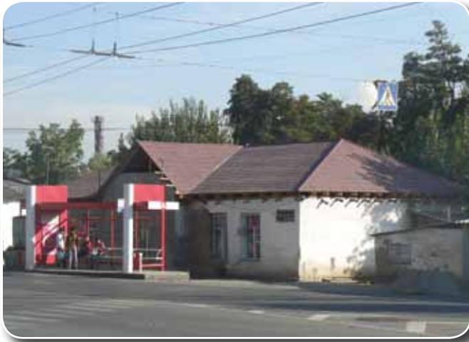
Nasza kaplica w Osz z nowym dachem.
