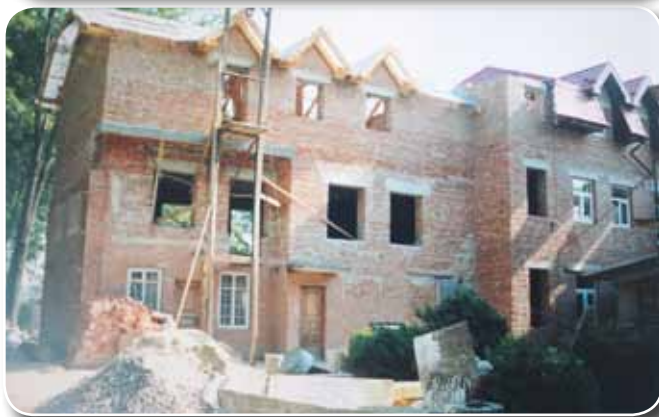
Budowa domu rekolekcyjnego.
