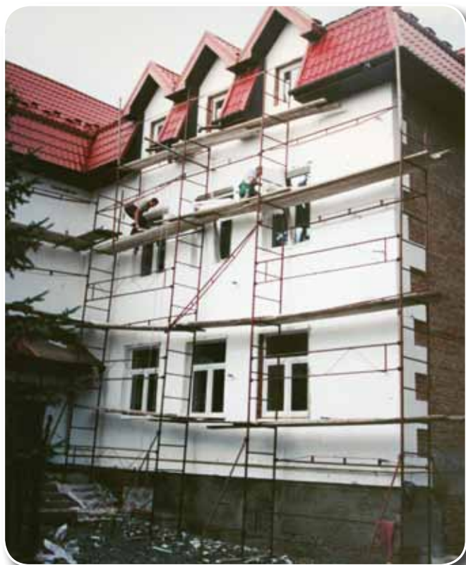
Dom rekolekcyjny w Chmielnickim – prace wykończeniowe.
