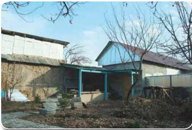
Wejście do remontowanego baraku.
