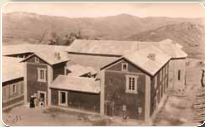
Budowa szpitala w Maranie.
