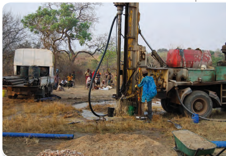
Wiercenie studni dla zaopatrzenia wioski w wodę.
