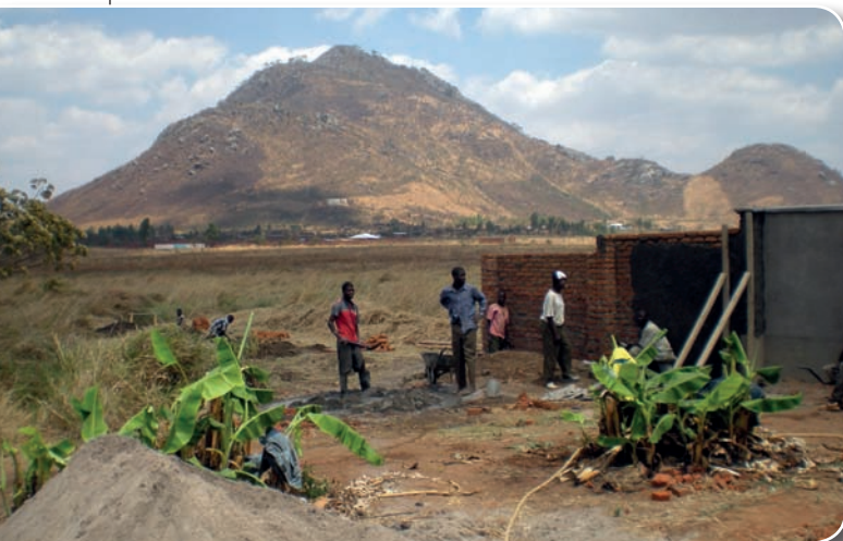
Grodzenie terenu pod budowę liceum w Kasungu, Malawi
