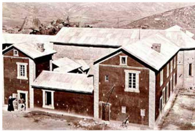
Kościół i dom wybudowany przez o. Jana Bezyima. Po lewej sala opatrunkowa i apteka, dom dozorczy i mieszkania chorych.
