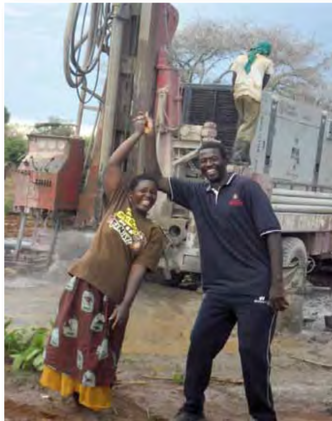
Wiercenie studni w Hampongo.
