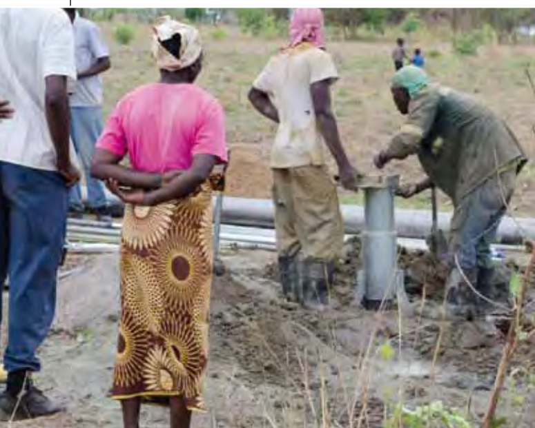
Zakładanie pompy ręcznej.
