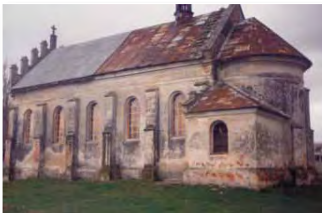
Remont kościoła w Batiatyczach k. Kamionki Strumilowej na Ukrainie.
