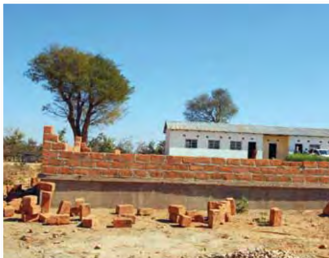
Rusza budowa kolejnej szkoły radiowej.
