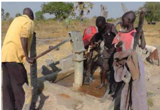
Nowo naprawiona studnia daje wodę do pojenia krów i do codziennych potrzeb mieszkańców wioski.
