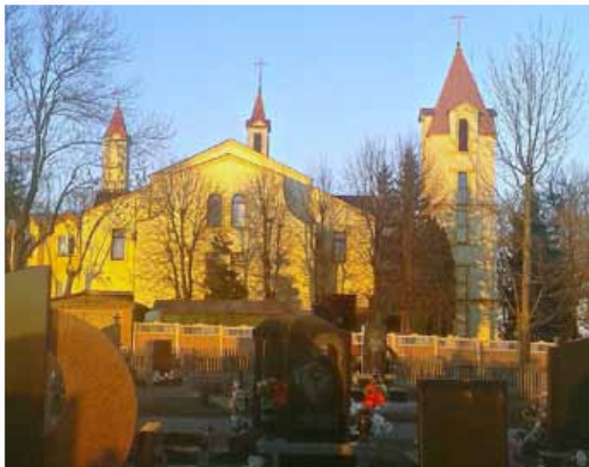
Kościół parafialny pw. św. Anny na Greczanach. Po prawej stronie nowo wybudowana wieża z dzwonami. Na lewo od niej Kaplica Męczenników.
