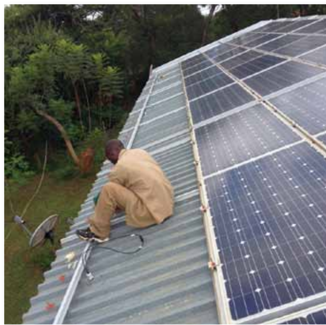
Instalacja dachowych paneli słonecznych.
