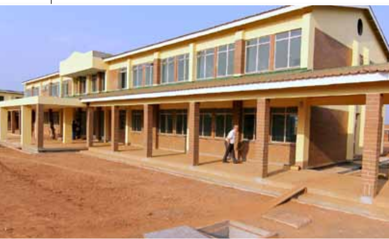
Szkoła średnia w Kasungu w Malawi prowadzona obecnie przez jezuitów. Na zdjęciu jeszcze w trakcie budowy.
