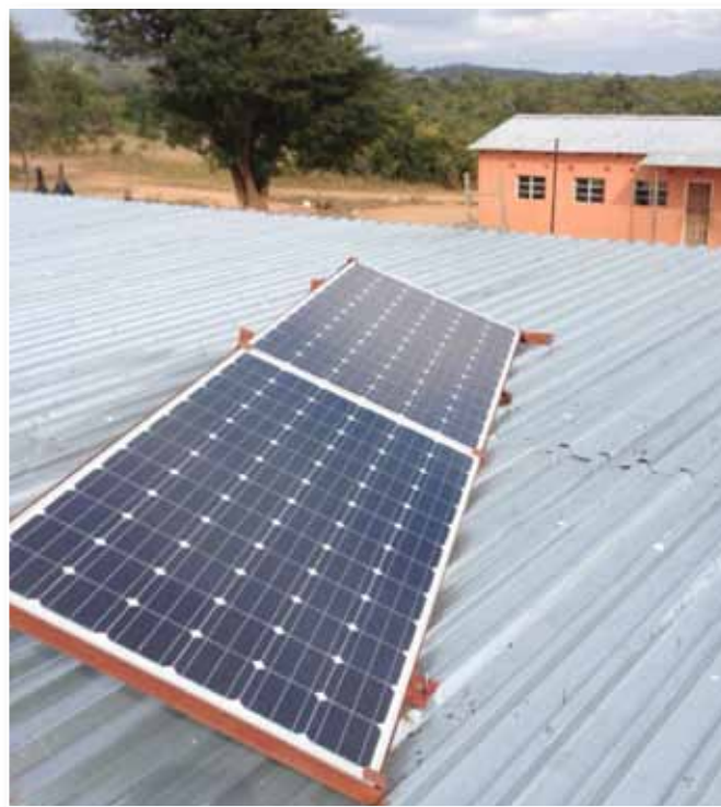
Nowo zainstalowany kolektor słoneczny na dachu szkoły.
