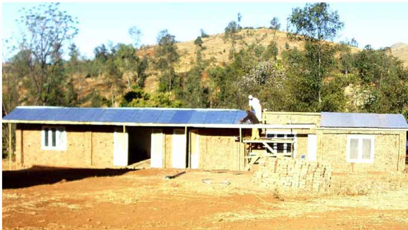
Budowa Collège'u Mampitsoa w wiosce Fialofa.
