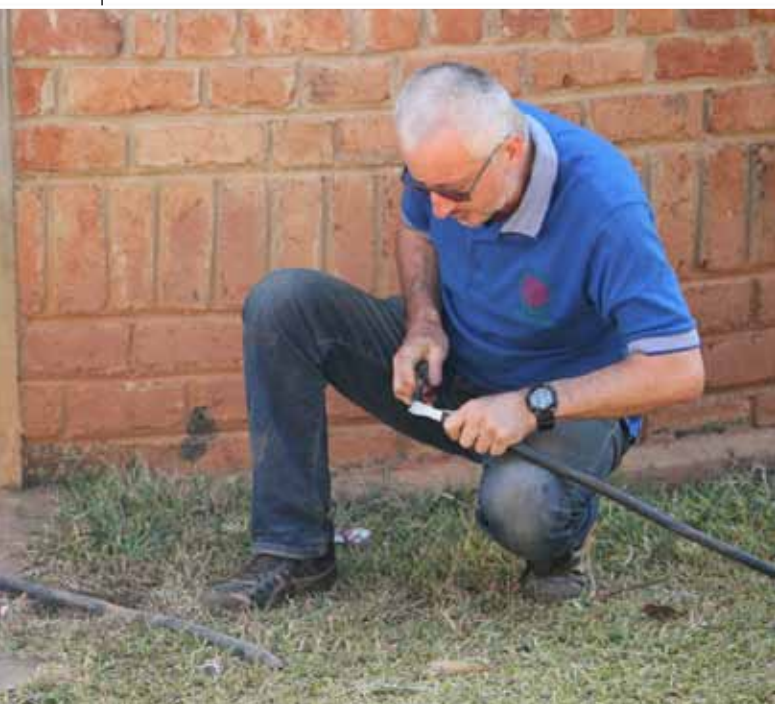
O. Andrzej Leśniara podczas instalacji przewodów elektrycznych.
