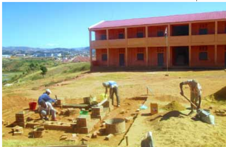
Prace przy budowie hydrantu dla sierocińca.
