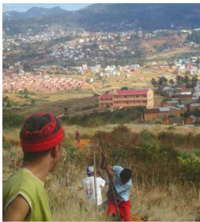
Prace przy wykopie kanału dla rur doprowadzających wodę.
