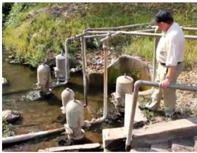
Taran hydrauliczny – urządzenie samopompujące wodę przy tamie zbudowanej na strumieniu w Katondwe.
